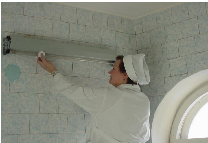
Рис. 6.9.4. Очистка поверхности УФ облучателя
