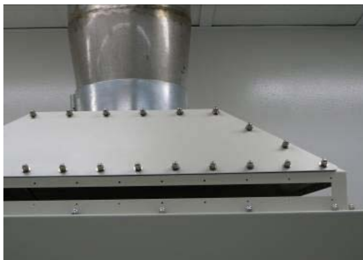
Рис. 6.3.3.2. Негерметичное подсоединение ШББ класса I и IIА по типу зонта или наперстка
