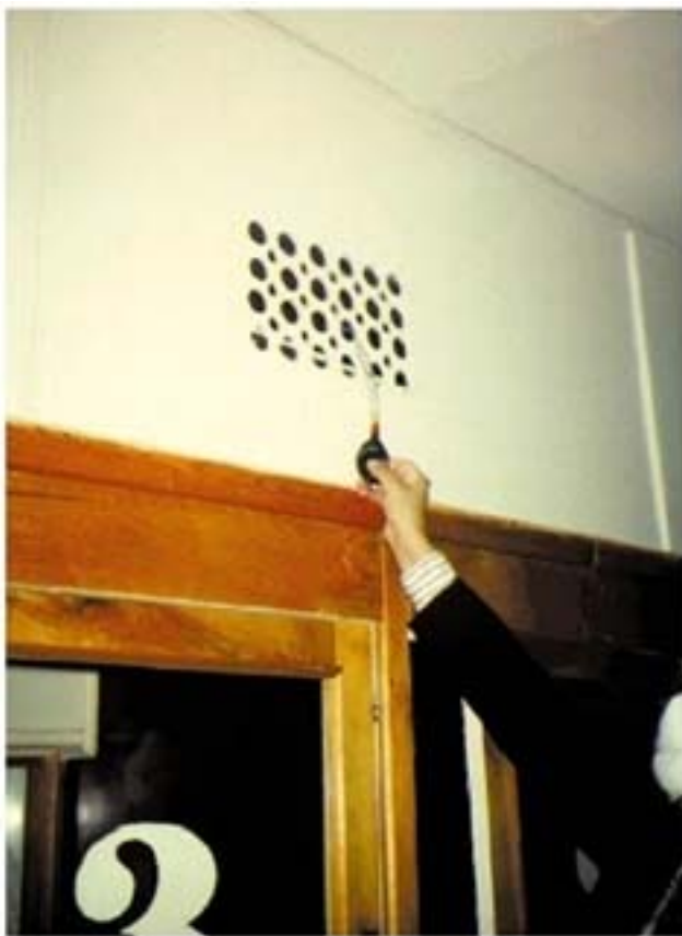
Рис. 6.3.2.2. Использование дыма для мониторинга вентиляции в блоке сбора мокроты
